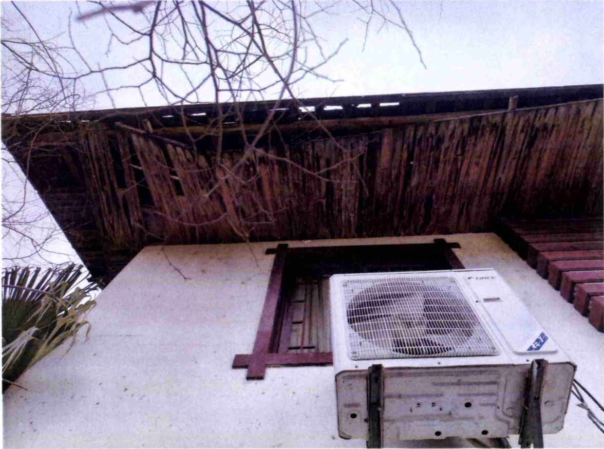
6~7×G 轴木构件的连接松动, 即将脱落
