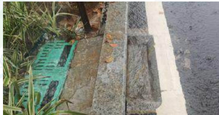
引水石+开口路缘石+截污框实拍 (建安大街南侧周边市政道路项目)
