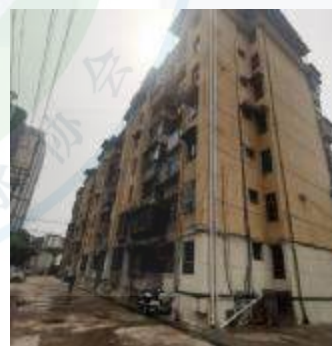
混接立管改造
