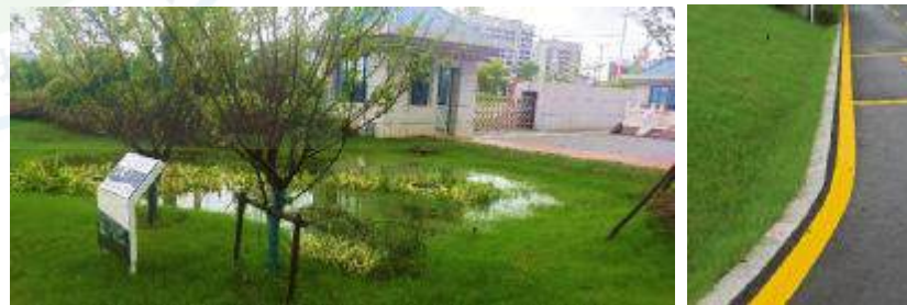
项目海绵设施实拍
