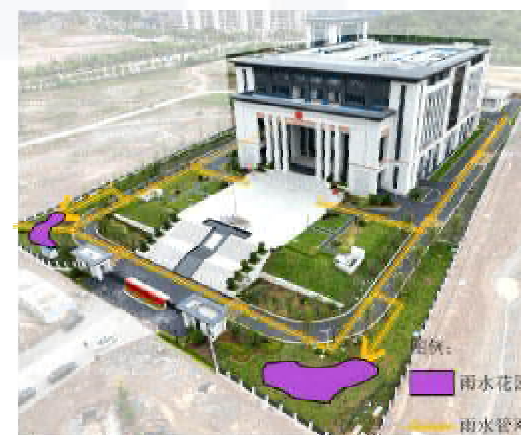
项目海绵设施实拍
