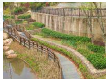
源头减排措施 (雨水立管断接、小区末端排口湿地)
